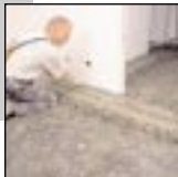
Tip AL 2L-2G: Şap malzemesinin dengelenmesi.
