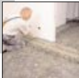
Tip AL 2L-2G: Şap malzemesinin dengelenmesi.
